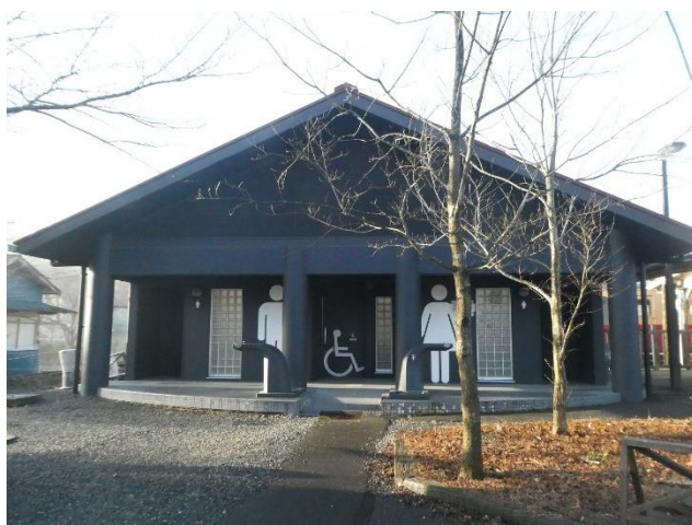
養老溪谷駅トイレ写真
